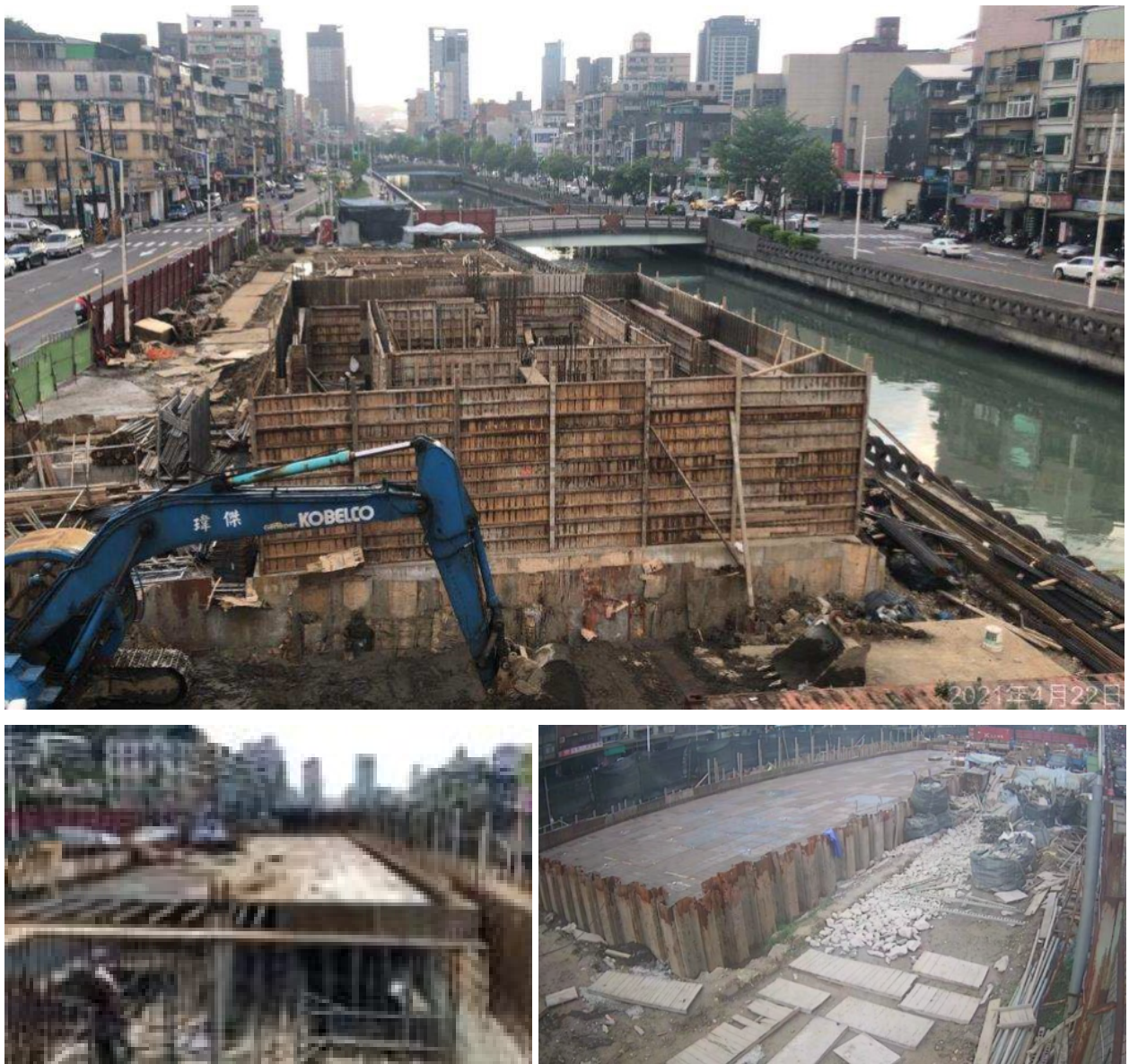
圖 4-31 田寮河上游(旺牛橋至迴船池)礫間處理施工現況
