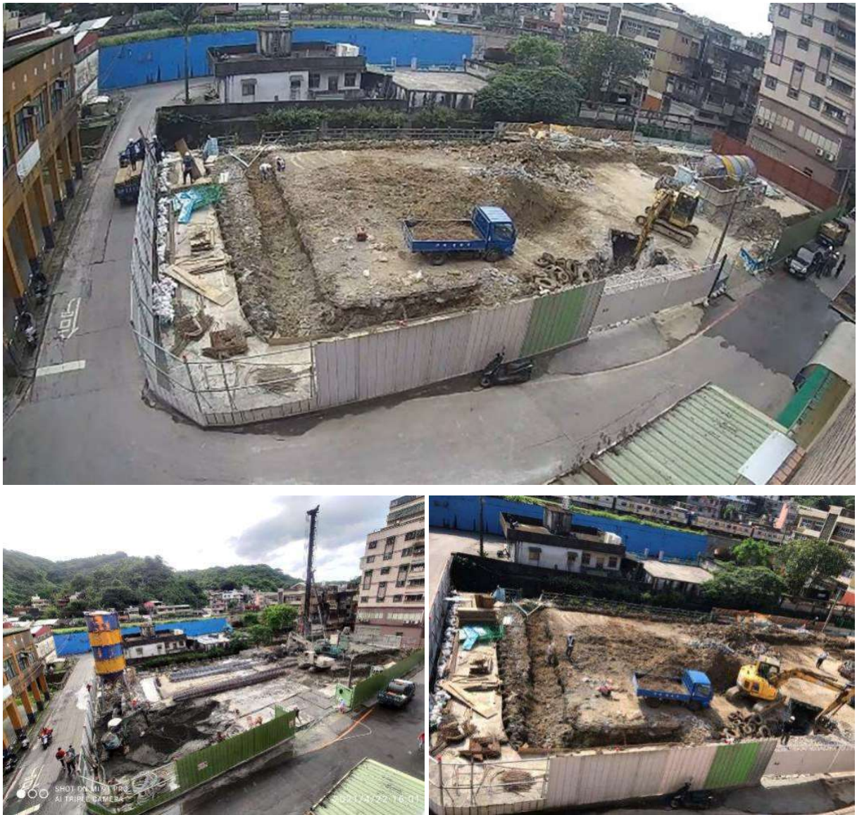
圖 4-39 南榮河水質提升現地處理工程施工現況
