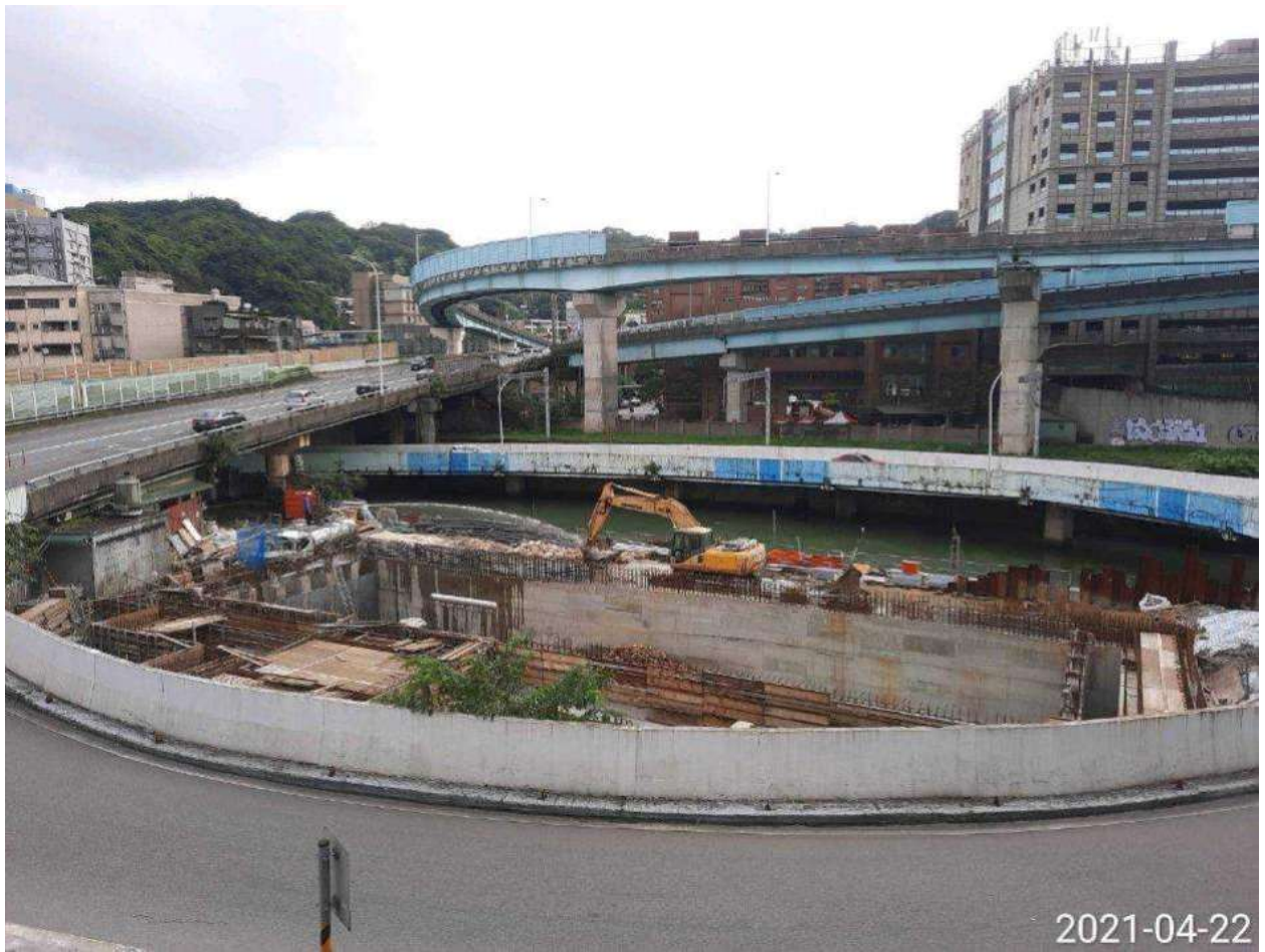
圖 4-35 旭川河現地處理設施施工現況
